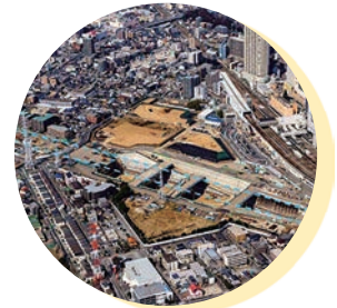
リニア中央新幹線 神奈川県駅(仮称)周辺の整備
