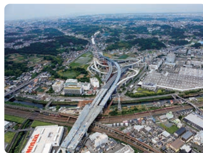
高速横浜環状南線 栄インターチェンジ・ジャンクション
