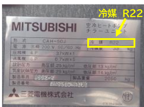
空冷ヒートポンプチラーの銘板 (冷媒ガスに R22 を使用)
