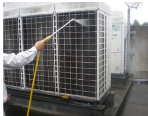
室外機のフィンの洗浄の様子
