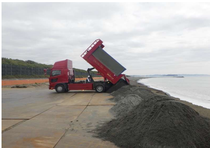
図3 令和5年度の養浜工事の状況（養浜材運搬）
