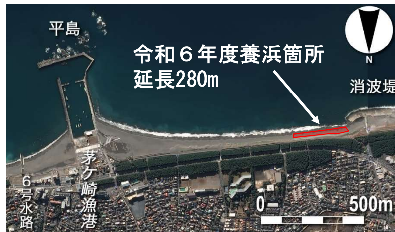
図1 令和6年度の養浜工事（柳島地区）
