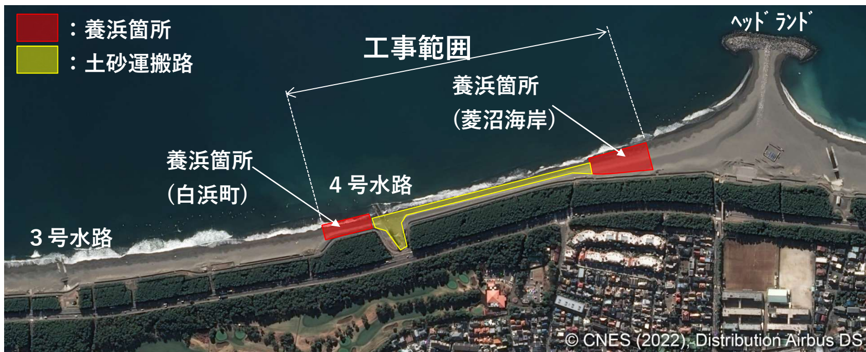
図5 令和6年度の養浜工事（菱沼海岸地区）
