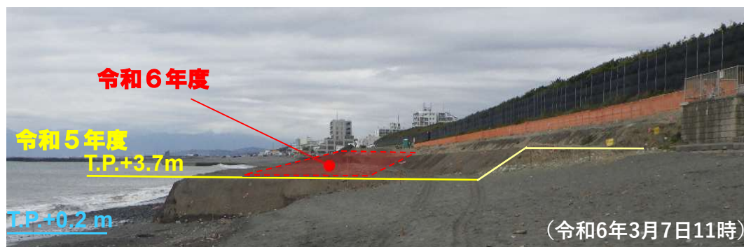
図4 中海岸の養浜盛土の状況と盛土の天端高
