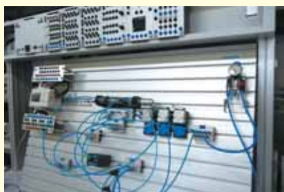
制御技術実験室
