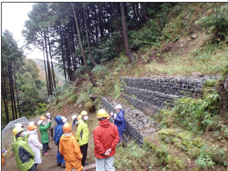
▲現場視察の様子
