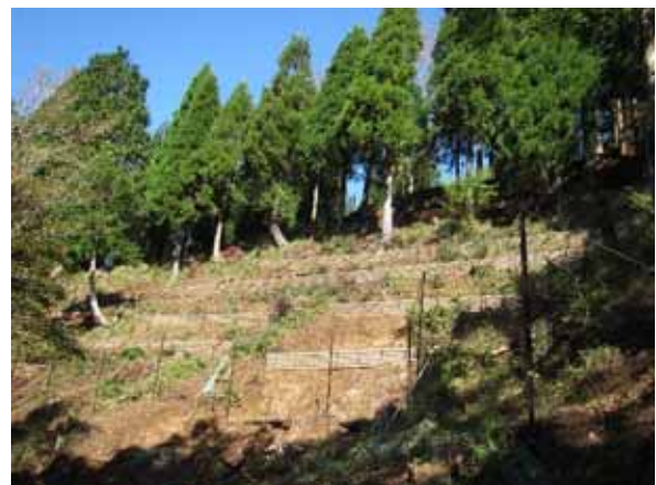
写真2-2 植生保護柵・丸太柵を設置した箇所 [県有林・愛甲郡清川村煤ヶ谷]
