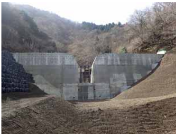
写真4-7 谷止工（透過型）[足柄上郡山北町山市場]
