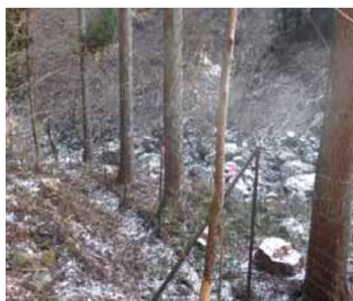
写真9-2 令和4年度間伐、植生保護柵補修箇所 (施工直後) [愛甲郡清川村煤ヶ谷]
