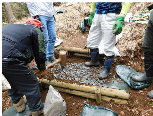
登山道を補修している様子
