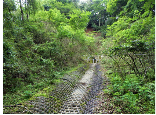
治山事業施工後6年経過した法面
