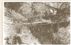
伏流水取水工事の様子
