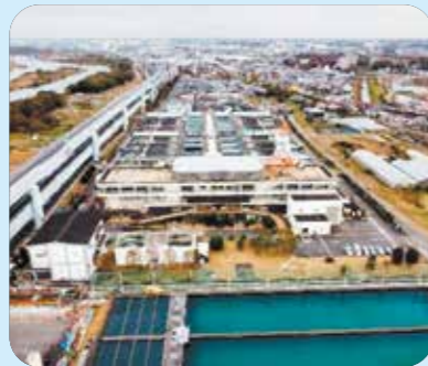
寒川浄水場の管理本館・特高受電棟
