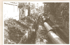
水道管工事の様子
