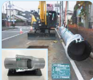
耐震継手管の埋設工事
