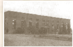
寒川送水ポンプ所(現 水道記念館)
