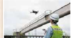
ドローンで点検をしている様子
