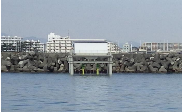
波力発電施設（撤去前）
