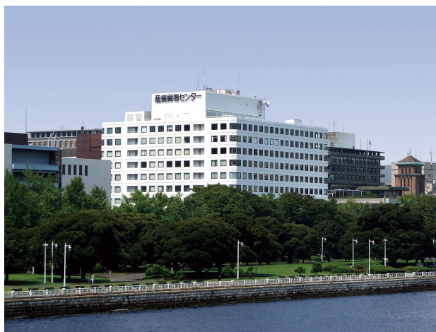
【産業貿易センタービル】
