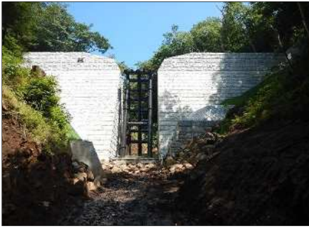
宮沢川1号堰堤 宮沢川 (小田原市)
