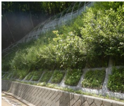
無種子の厚層客土吹付工施工地
