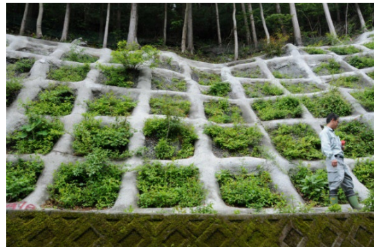
飛来種子捕捉マット施工地
