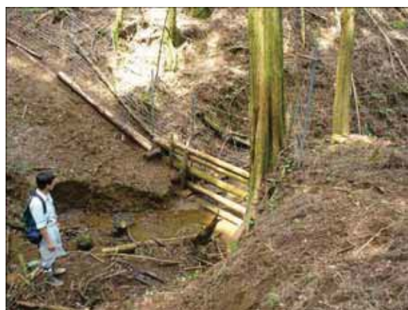
点検・補修した獣害防護柵
