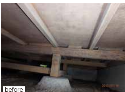
リフォーム前の断熱材のない床
