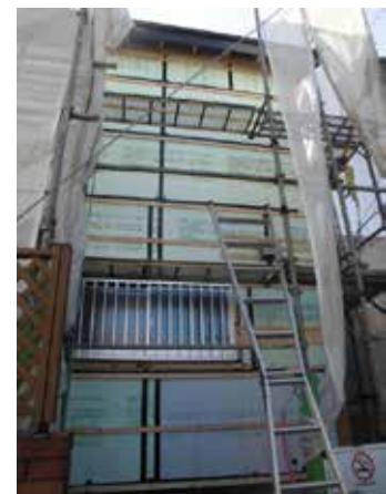
外壁の外張断熱の施工の様子
