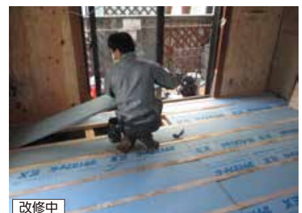
断熱材の敷き込み
