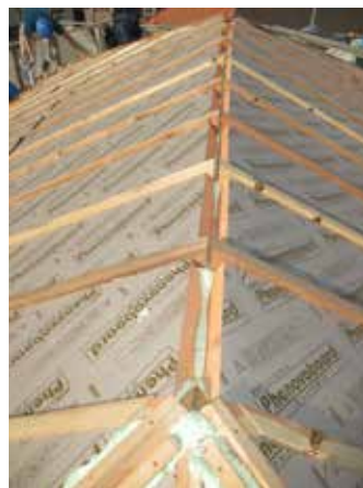
9センチ厚の断熱材（左）を敷き詰めた屋根の改修（右）
