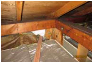
外観（上）と屋根裏の様子（下）
