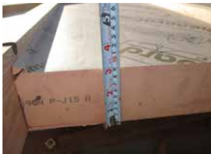
9センチ厚の断熱材（左）を敷き詰めた屋根の改修（右）
