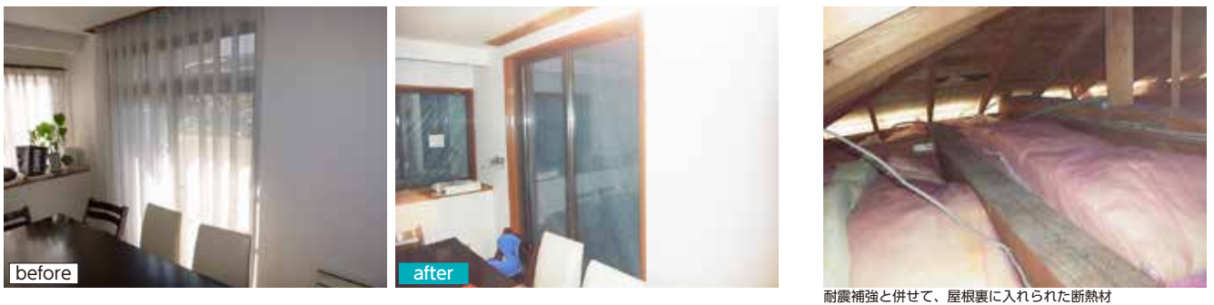
耐震補強と併せて、屋根裏に入れられた断熱材
