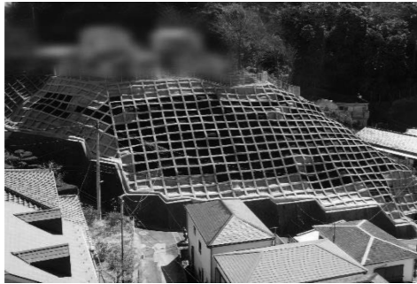
急傾斜地崩壊防止施設整備
