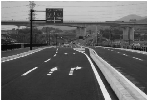
県道603号(上粕屋厚木)整備
