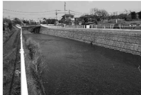
引地川護岸整備
