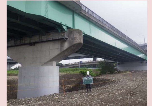
補強後の状況 (P1)
