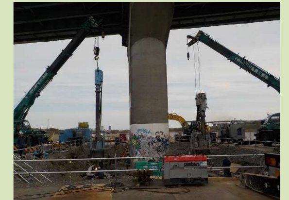
施工状況 (P4)
