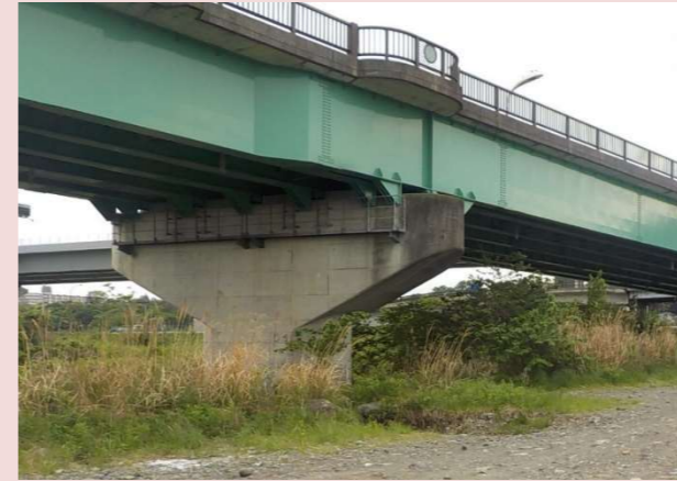
補強前の状況 (P1)
