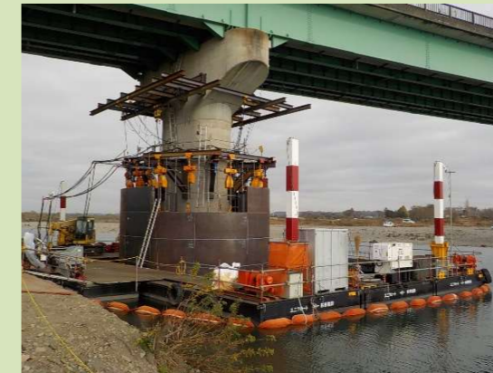
施工状況 (P2)
