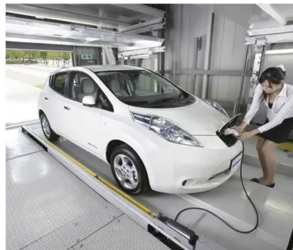
機械式駐車場への充電器設置例 新明和工業株式会社HPより
