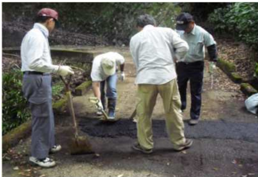
農道の維持補修
