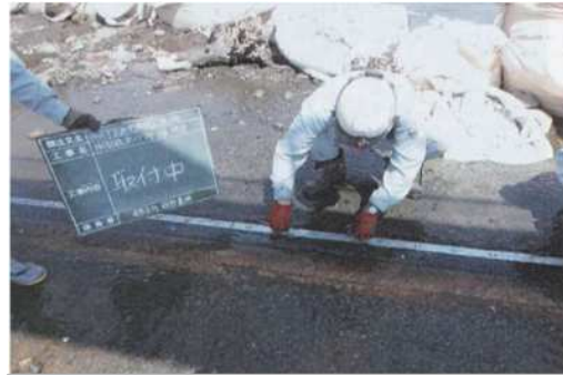
取水門の補修
