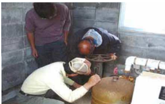
畑かん用ポンプの軽微な補修
