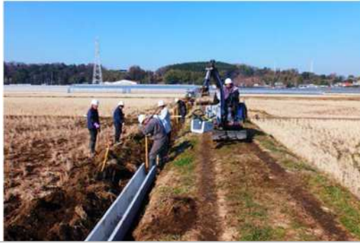
老朽化水路の更新
