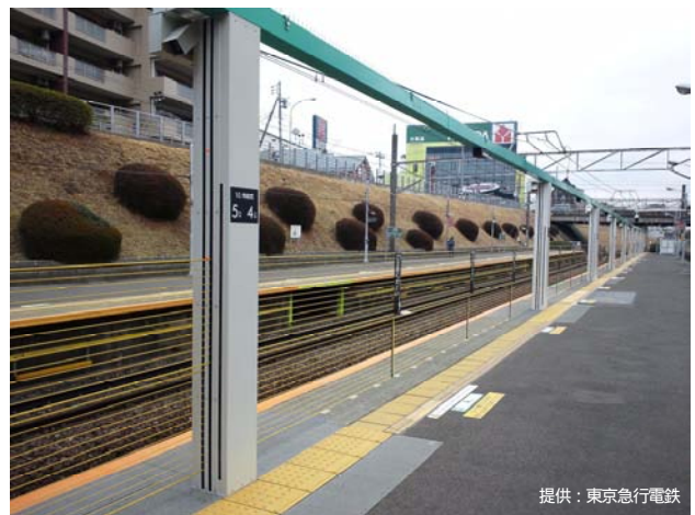
写真13：つきみ野駅での昇降式ホームドア実証実験
