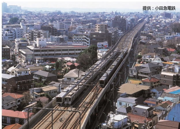
写真2：高架複々線（経堂駅～千歳船橋駅間）
