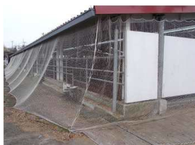
防鳥ネットの補修
