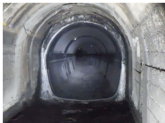
改修中の農業用水路（水路トンネル）
