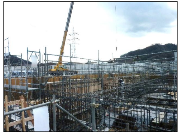
図一6 ポンプ所の建設
