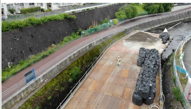
藪根橋下流（整備中箇所）
