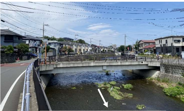
福田8号橋付近（整備済箇所）
