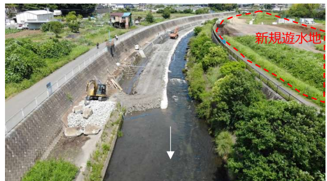
新規遊水地付近（整備中箇所）
