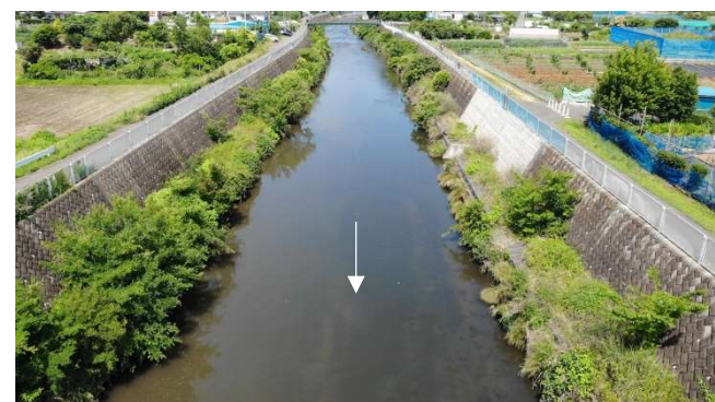
坂下橋上流（整備済箇所）
