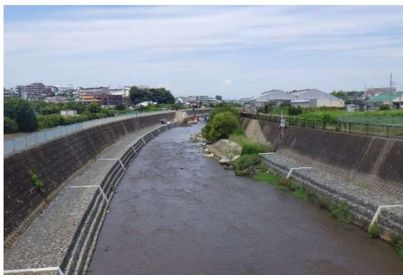
護岸整備状況
