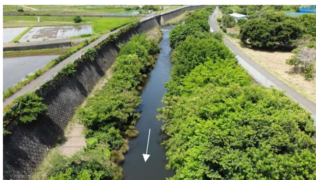
恩田川大橋上流（未整備箇所）
