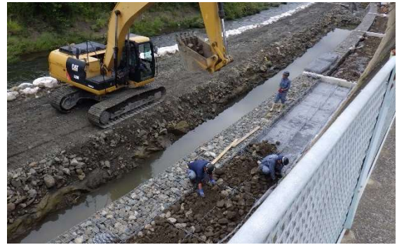
かご枠の施工状況
