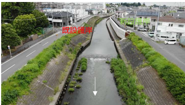
境橋下流部（未整備箇所：右岸）
