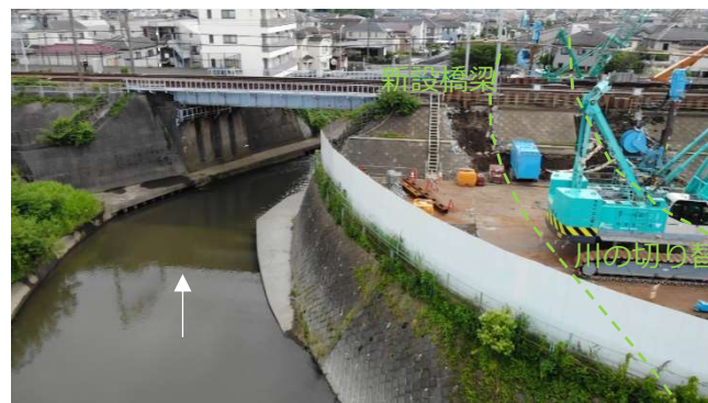
相鉄線交差部（整備中箇所）
