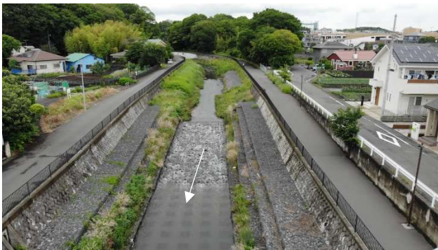
根岸橋上流（整備済箇所）
