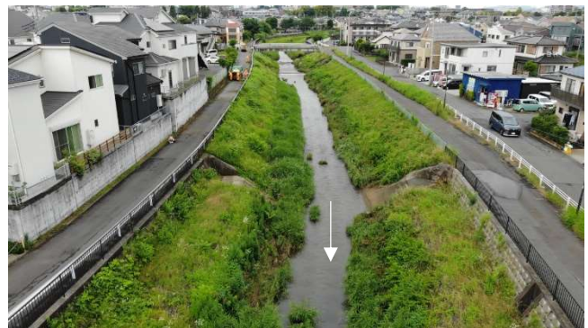
共和橋上流（未整備箇所）
