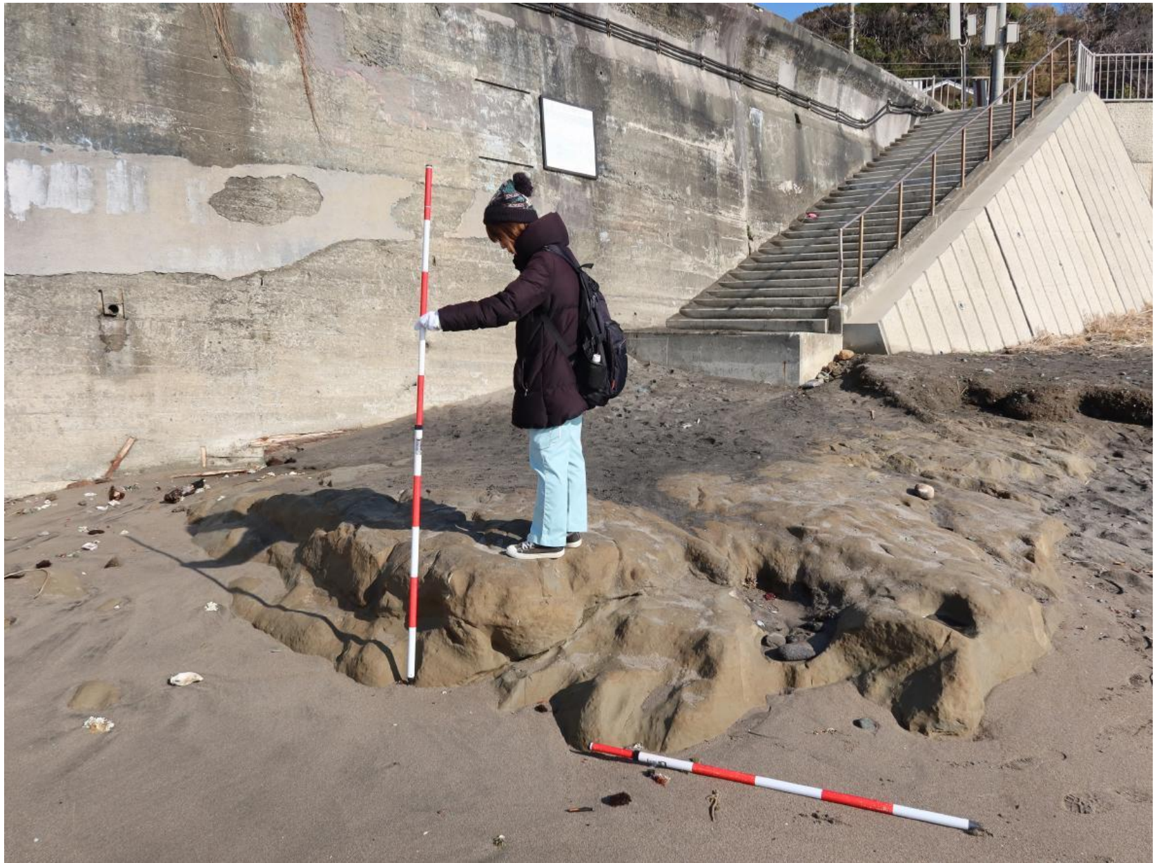
写真-1 駐車場の東側面にある階段下の砂浜上には、軟岩層が比高約45 cmだけ露出
