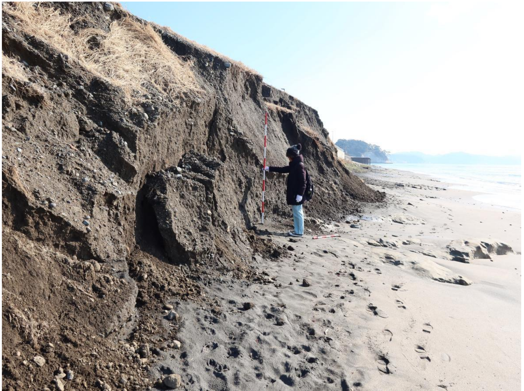
写真-6 盛り土区間の東端部の状況 同様な盛り土の崩れが観察された.
