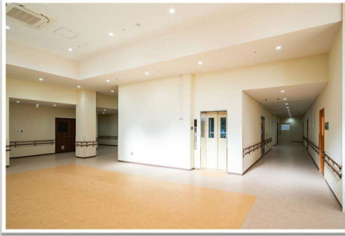
エレベーター
