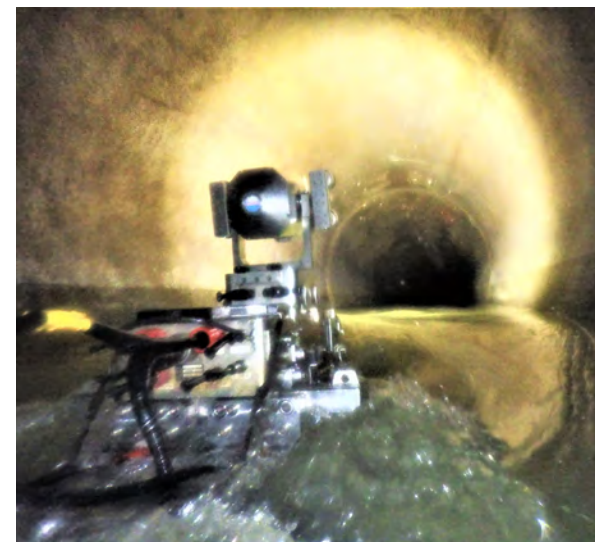
写真: 下水道の管渠内の無人点検の様子
