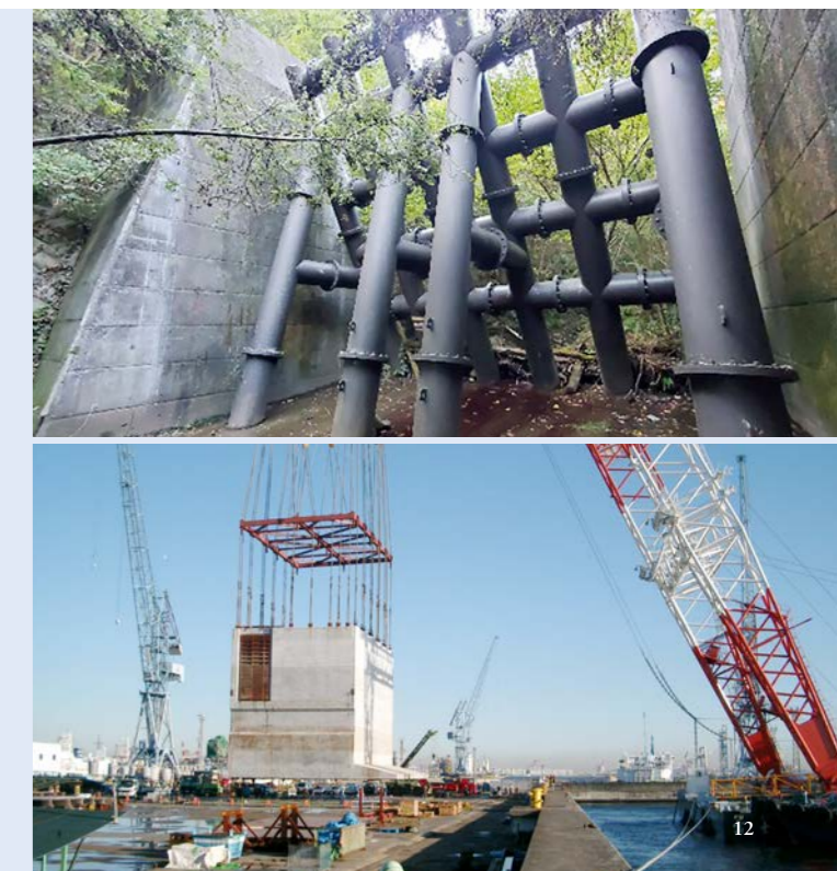
写真上：現在所管している砂防堰堤 写真下：防波堤のケーソン据付工事
