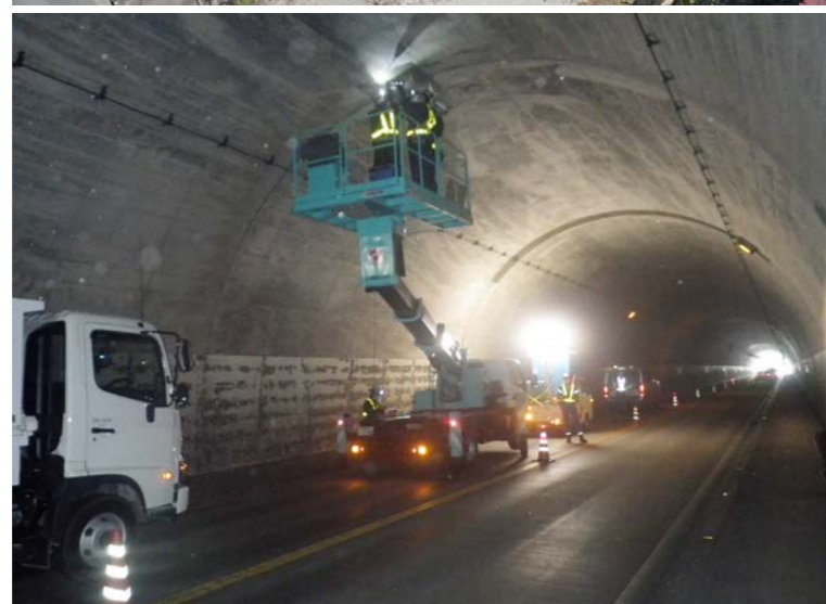
写真上: 整備を進めている県道42号藤沢座間厚木(厚木市) 写真左下: 県道514号宮ヶ瀬愛川 施設の長寿命化を図るための宮ヶ瀬トンネルの点検 写真右下: 国道134号鎌倉高校前交差点の改良工事 (右折レーン設置+歩道拡幅整備)
