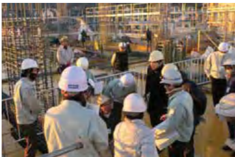
上: 本庁舎の建築について学ぶ研修 下: 営繕工事現場の現場研修/営繕の監督・検査に必要な知識と、建築行政の審査・検査に必要な知識を両面から学びます
