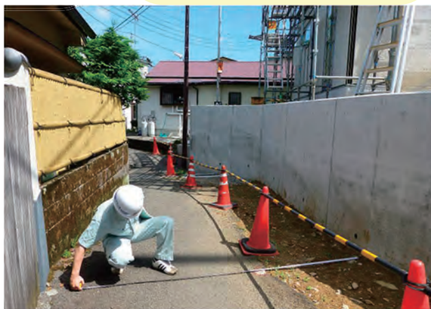
建築物のパトロール
