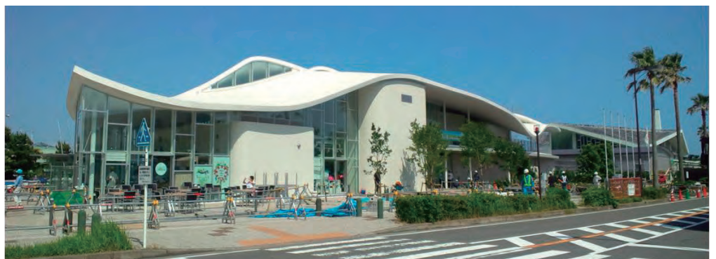
湘南港港湾管理事務所 新築工事
