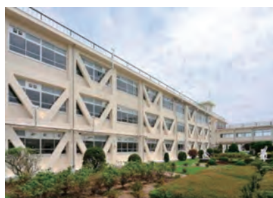
西湘高校 耐震補強工事
