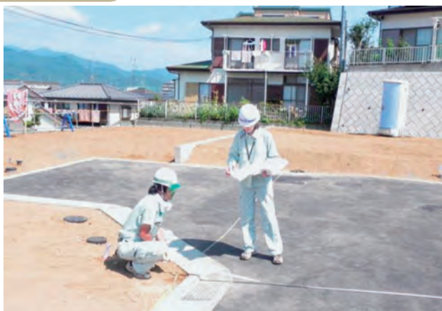
開発許可の現場完了検査
