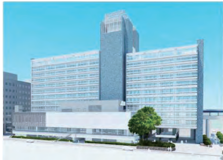
新庁舎の免震改修工事と エネルギーセンター棟増築工事
