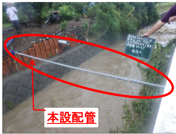
本復旧後 (本設配管)
