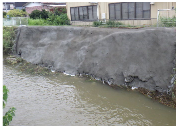
応急復旧後 (モルタル吹付)
