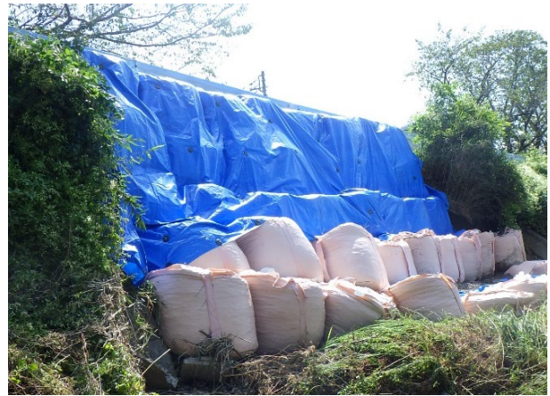
応急復旧後 (大型土のう設置)
