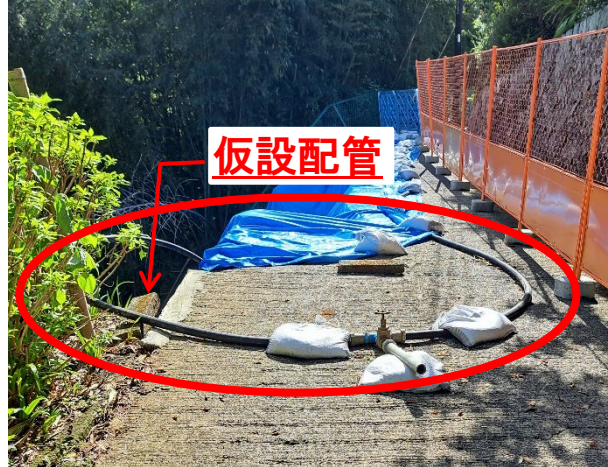
応急復旧後 (仮設配管)
