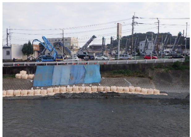
応急復旧工事中(コンクリート打設)
