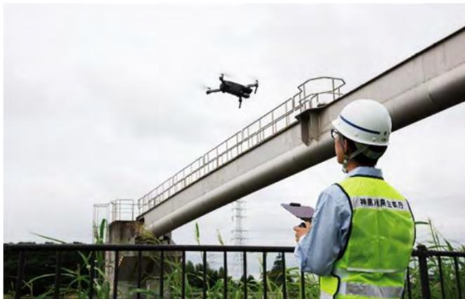
ドローンによる水管橋の点検
