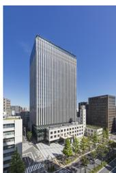
「川崎市役所本庁舎」は、市民に親しまれてきた旧本庁舎の跡地に建てられた都市型防災庁舎である。多摩川の浸水被害を受けないよう中間階免震構造を採用するなどあらゆる都市災害が想定されている。超高層建築での自然換気導入、旧本庁舎の一部の新築復元、低層階に市民利用可能な会議室を集約する計画上の工夫など総合的に優れた建築となっている。
