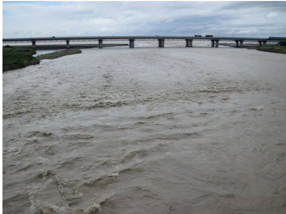
写真1 濁流となった酒匂川河口の様子
