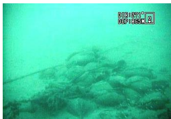
図5-23 碇（土俵）の設置状況
