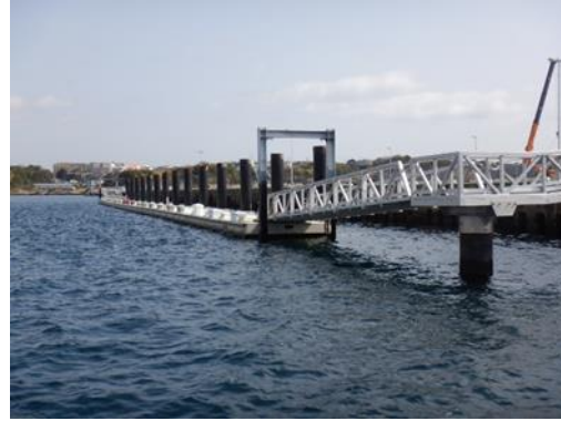
三崎漁港二町谷地区の浮棧橋
