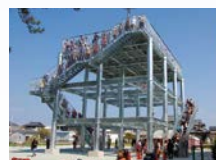
津波避難タワー
