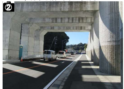
・ 2車線供用区間の状況
