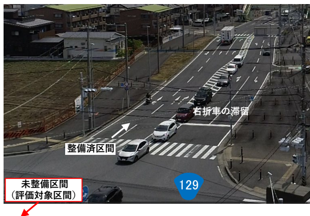
供用済区間の状況(東真土二丁目交差点)
