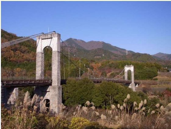
公園のランドマークである「風の吊り橋」
