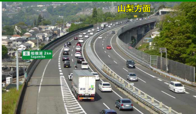
中央自動車道 相模湖付近(下り線)混雑状況
