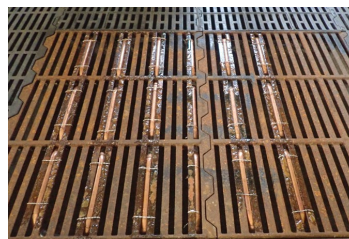
豚房床面の改良 (床冷却) ・母豚の胸部の床裏に銅管で冷水を循環 ・水温は井戸水の利用を想定して 18℃に設定
