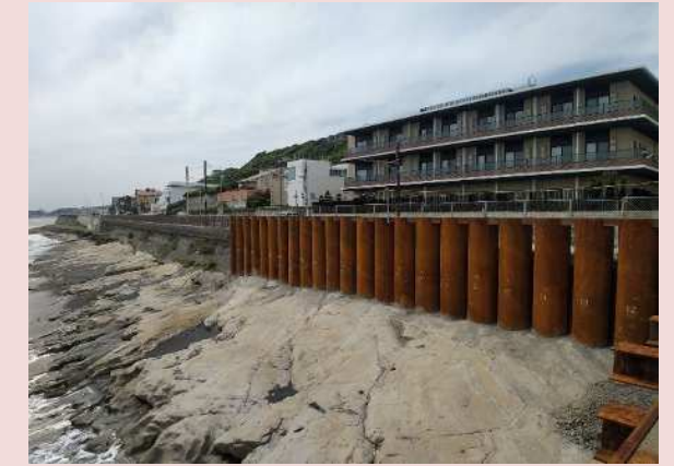
杭打設後の状況
