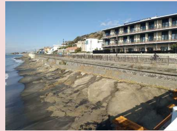
改修前の状況
