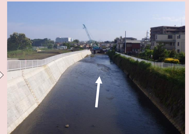
改修後の状況(熊野橋下流)
