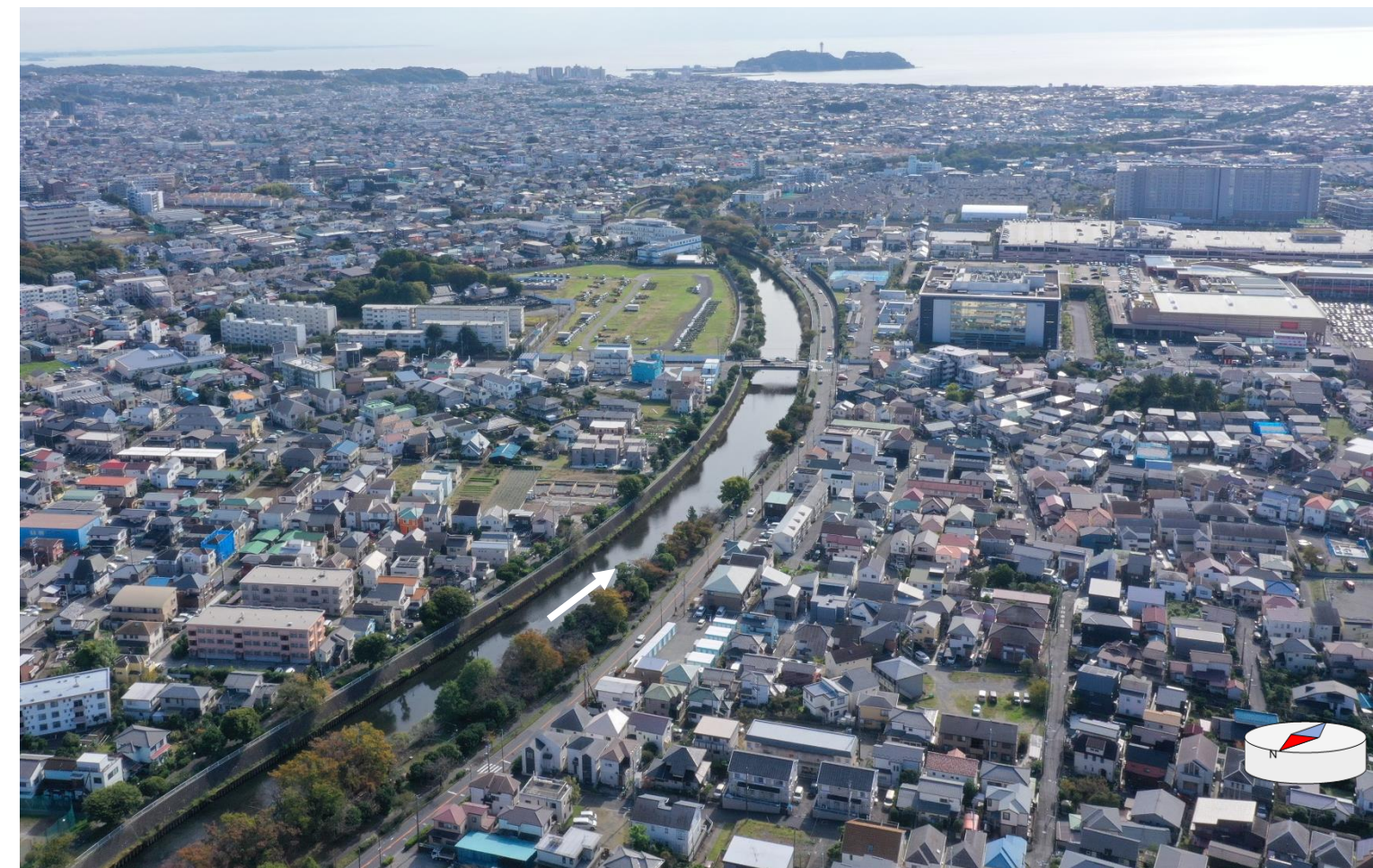
上村橋上流付近 令和6年11月撮影
