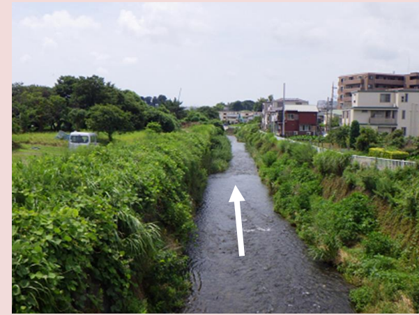
改修前の状況(熊野橋下流)
