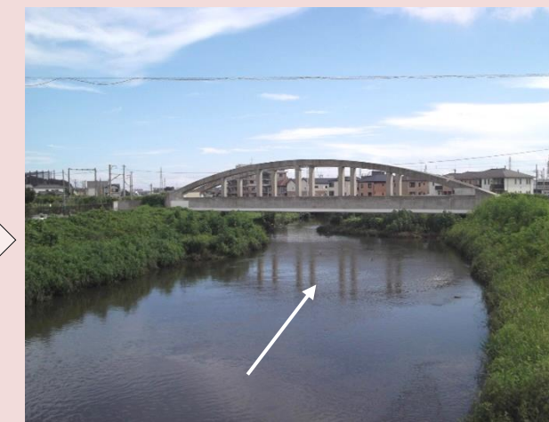
改修後の状況(寺尾橋下流)
