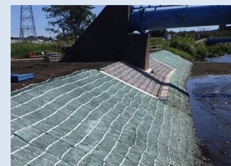
護岸ブロック+覆土構造
