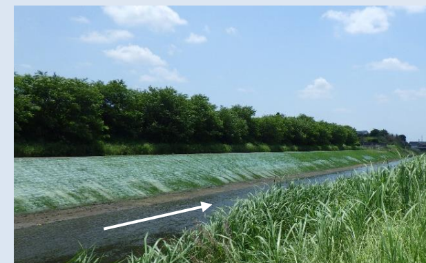
覆土には発生土や植生マットを利用することで在来植生の回復や法面の保護を配慮
