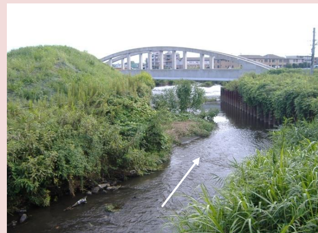
改修前の状況(寺尾橋下流)
