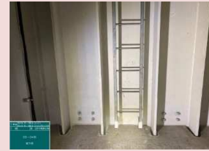
補強前の状況 (P2 主塔内部)
