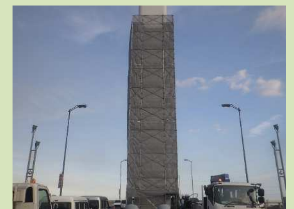
施工状況 (P3主塔)
