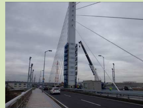
施工状況 (P2主塔)
