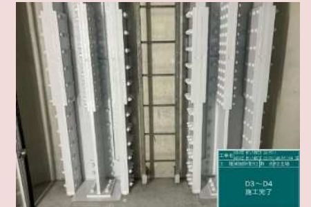
補強後の状況 (P2 主塔内部)
