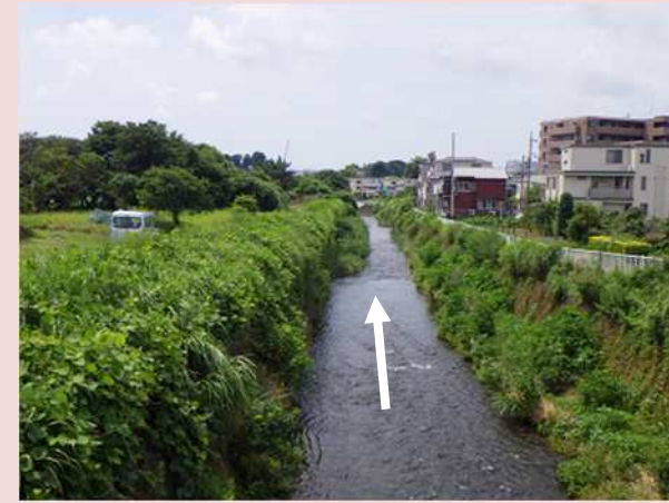
改修前の状況(熊野橋下流)
