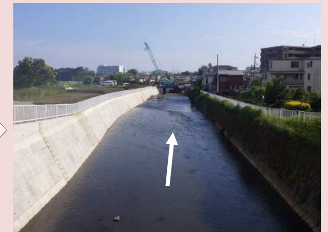
改修後の状況(熊野橋下流)
