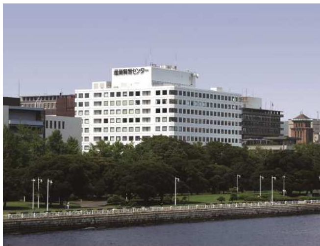
【産業貿易センタービル】
